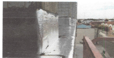
VISTORIA E RETIRADA DE CERÂMICAS PILARES - FACHADA LESTE
